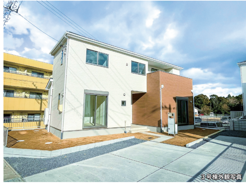
3号棟外観写真
